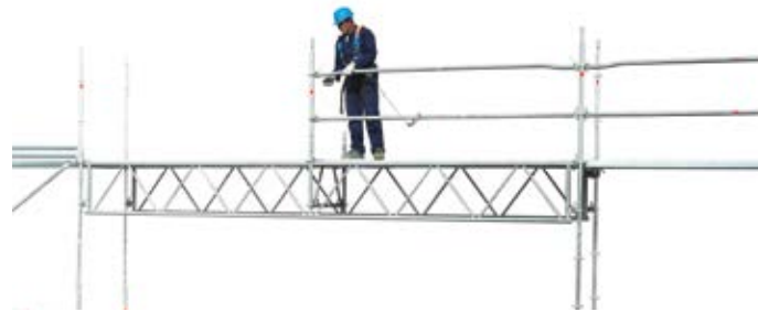
52 • montaż poręczy kratownicy wzmacniającej
