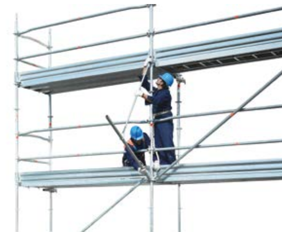
46 • montaż osłony odpryskowej
