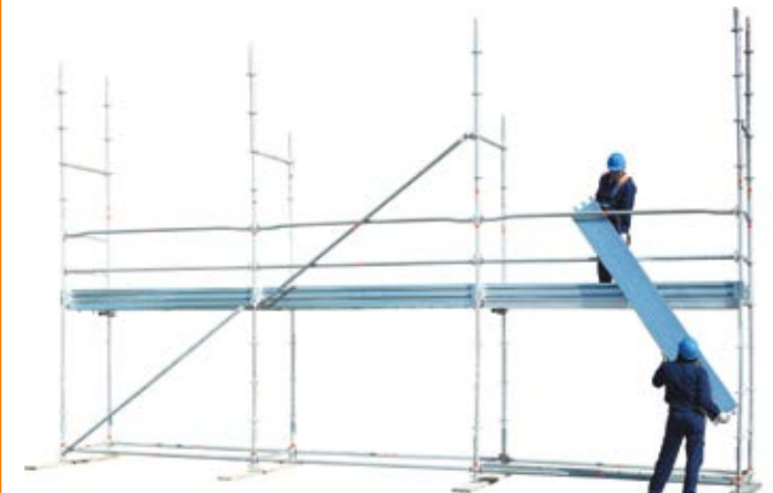
36 • montaż podestu na 2 poziomie
