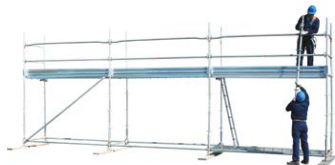
30 • montaż słupków górnych
