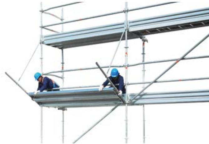
49 • montaż płyt osłony odpryskowej
