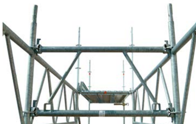
51 • montaż połączenia kratownicy wzmacniającej
