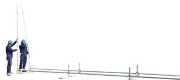
9 • montaż słupków
