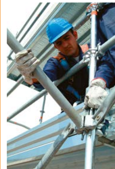
48 • montaż osłony odpryskowej
