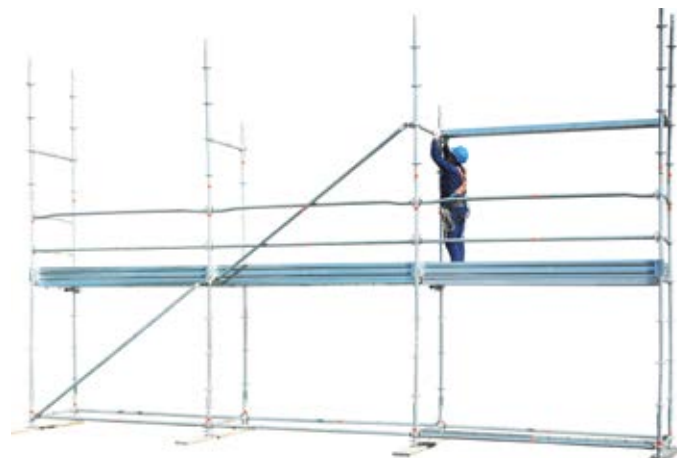
37 • montaż podestu na 2 poziomie
