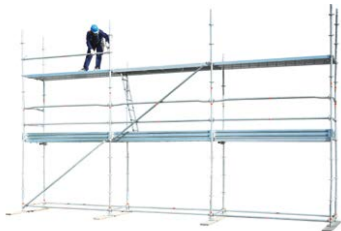
39 • montaż poręczy na 2 poziomie
