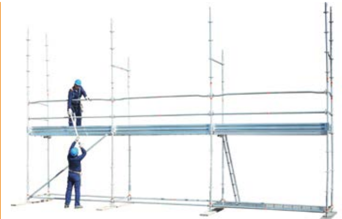
34 • montaż rygli i poręczy na 2 poziomie
