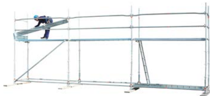
27 • montaż bortnicy czołowej
