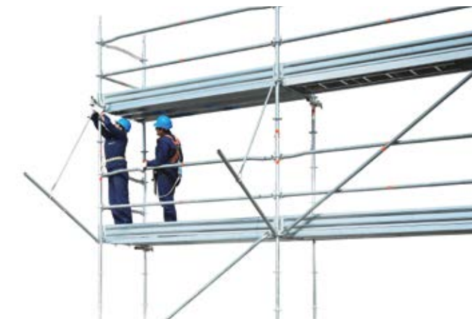
47 • montaż osłony odpryskowej
