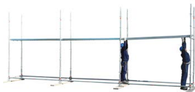
16 • montaż podestu wylazowego z drabiną
