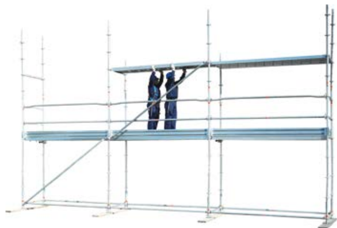
38 • montaż płyty podestowej z włazem
