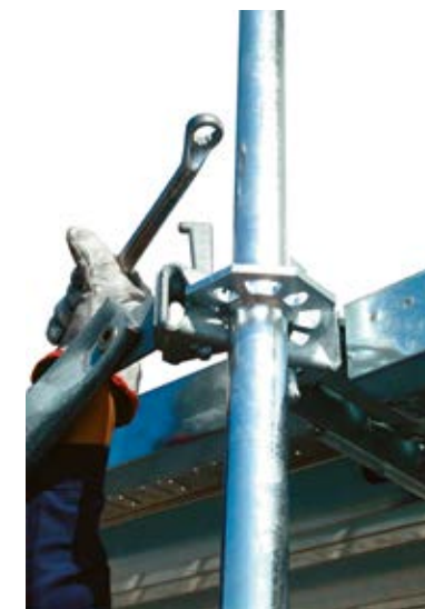
19 • montaż stężeń pionowych, zabezpieczenie klinem
