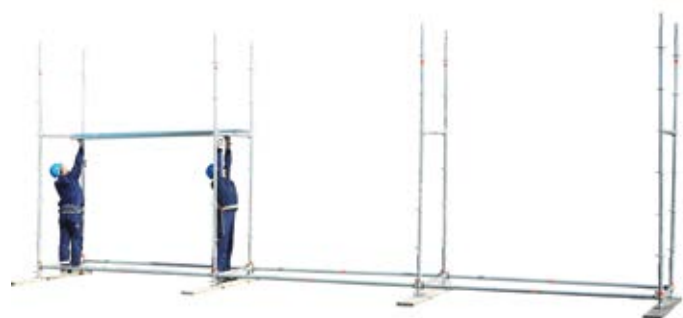
13 • montaż podestów stalowych
