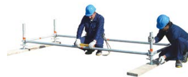
7 • poziomowanie wzdłużne
