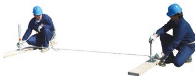
5 • ustawienie kolejnej sekcji
