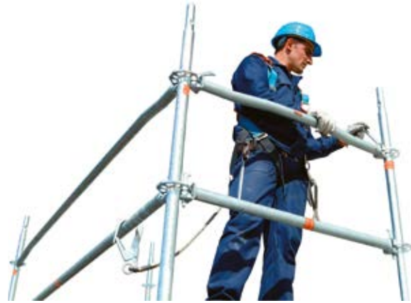
25 • montaż poręczy czołowej/rygla
