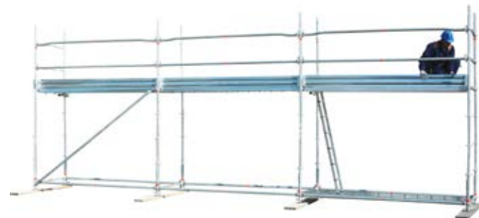
29 • montaż bortnic elewacyjnych
