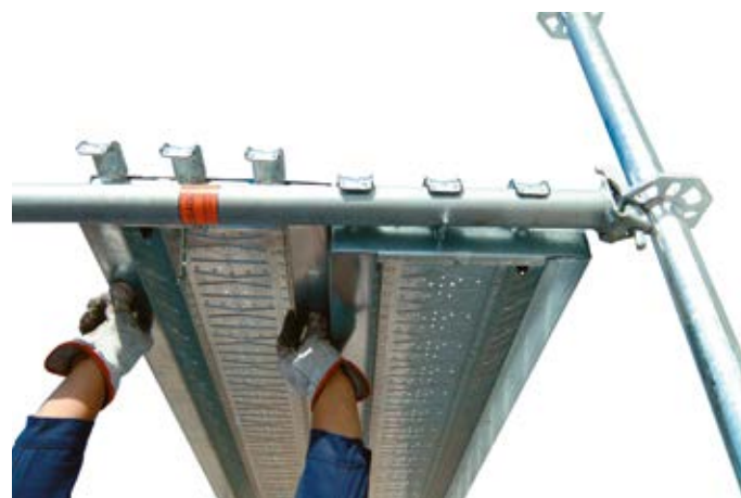
14 • montaż podestów stalowych
