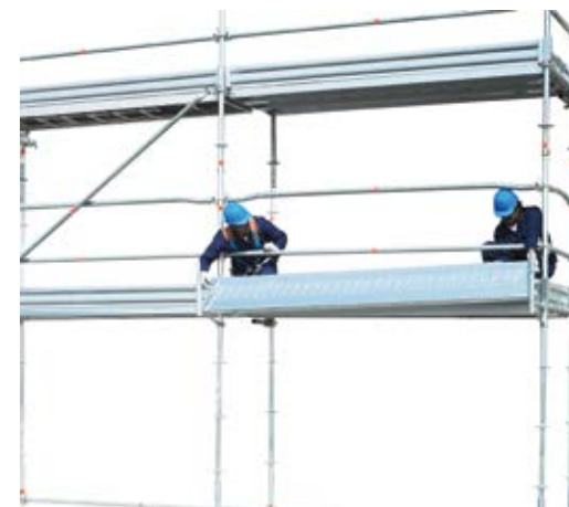
44 • montaż podestu do wsporników
