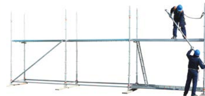
22 • montaż rygli/poręczy na 1 poziomie
