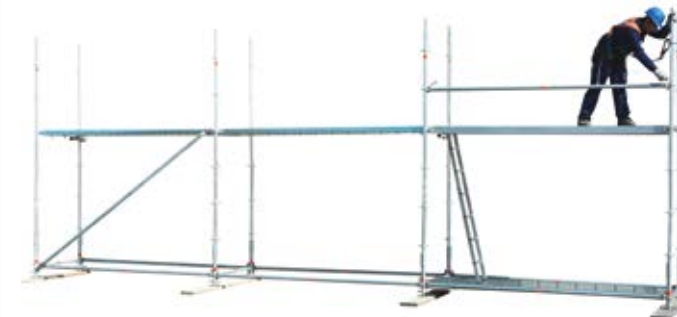
23 • montaż rygli/poręczy na 1 poziomie
