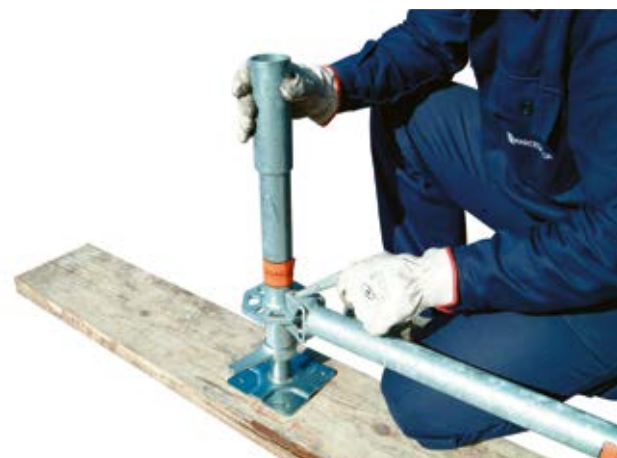
3 • montaż rygli z elementu początkowego
