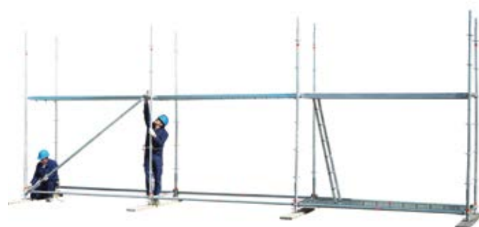
17 • montaż stężeń pionowych
