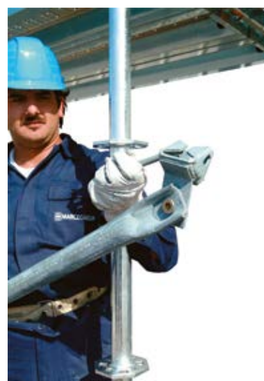
18 • montaż stężeń pionowych
