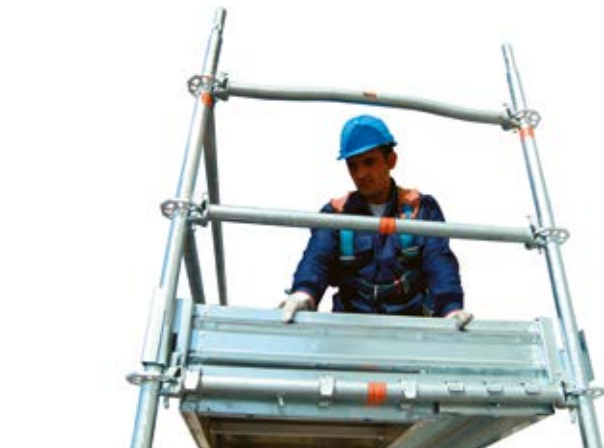
26 • montaż bortnicy czołowej
