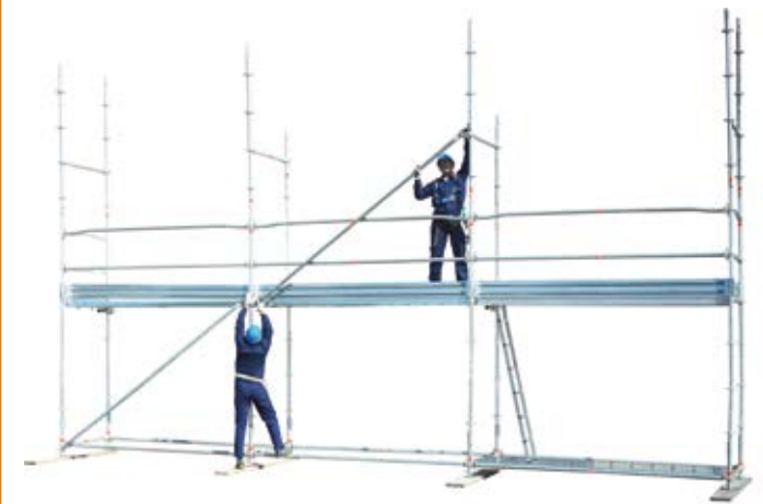
35 • montaż stężeń pionowych co 4 przesła na poziom
