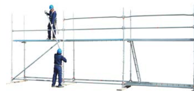
24 • montaż rygli/poręczy na 1 poziomie
