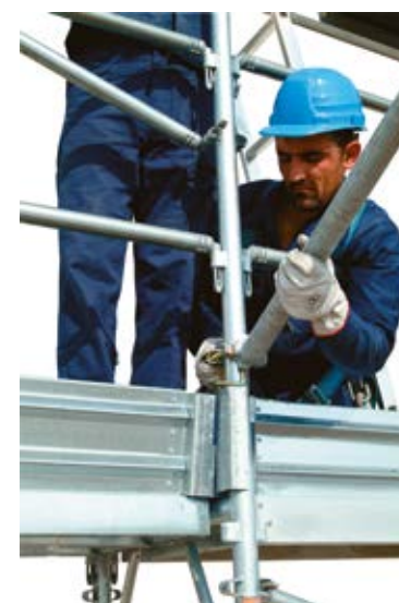
54 • detal wspornika osłony odpryskowej
