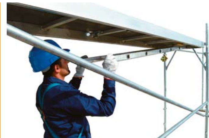
21 • wysunięcie drabiny z podestu włączowego
