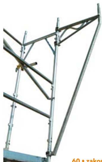
60 • zakończony montaż wspornika wraz z podporą
