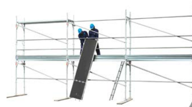
44 • montaż podestu włączowego na poziomie 2
