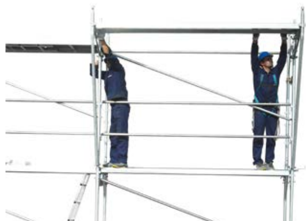
61 • montaż podestów na wsporniku
