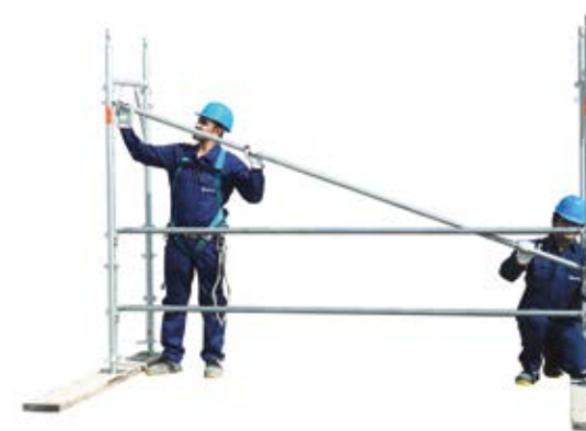
7 • montaż stężenia diagonalnego (krzyżowego)
