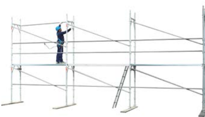
34 • montaż poręczy tymczasowej na poziomie 1
