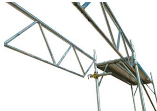
65 • montaż kratownicy sytemowej Realpont (wzmacniającej)
