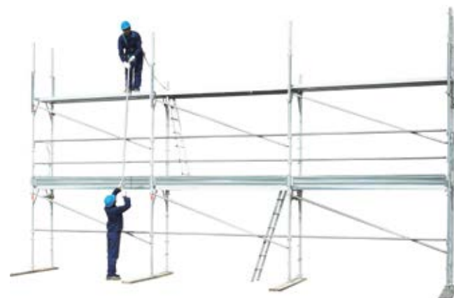
50 • montaż poręczy i poręczy balustradowej na poziomie 2
