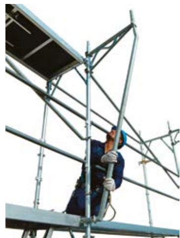
59 • montaż podpory wspornika
