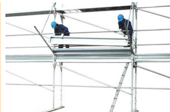
56 • montaż podestów do osłony odpryskowej cd
