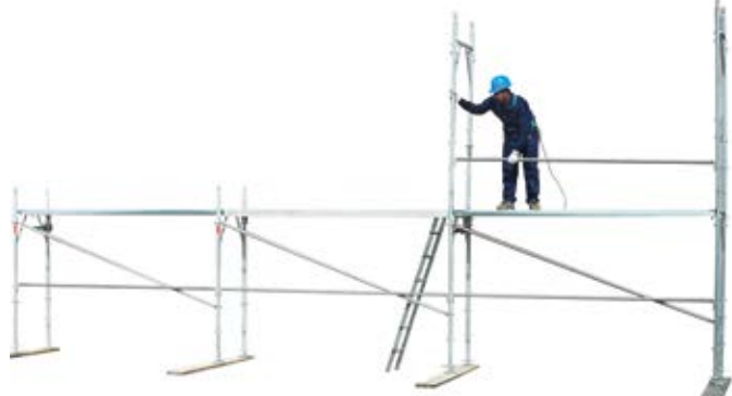
30 • montaż poręczy na poziomie 1
