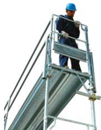
51 • montaż balustrady czołowej na poziomie 2
