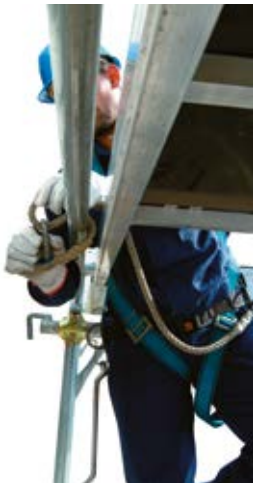
24 • podwiązanie liny zabezpieczającej przed wejściem na piętro
