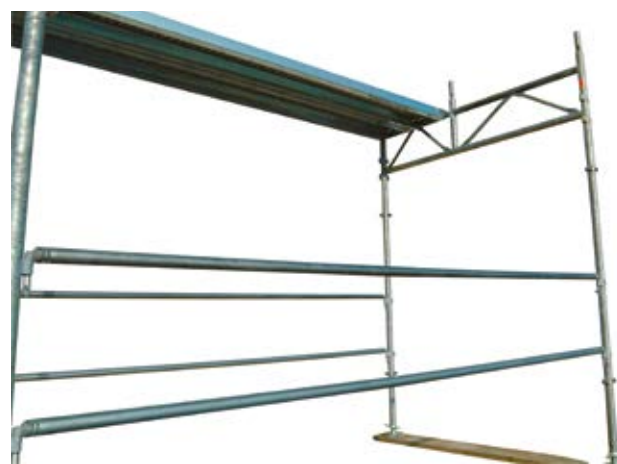
64 • montaż podestów na ramie nadchodnikowej
