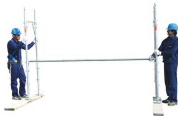
5 • montaż drugiej ramy wraz z balustradą
