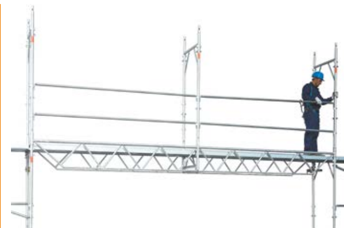
68 • montaż ram i poręczy nad wiązarami przejazdowymi
