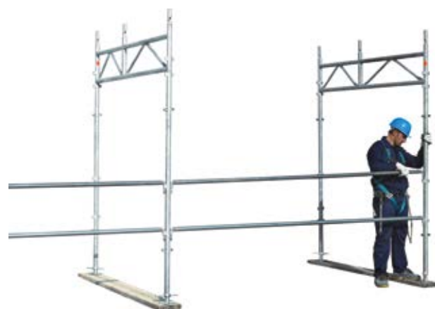
63 • montaż połączeń ramy nadchodnikowej
