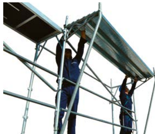
62 • montaż podestów na wsporniku
