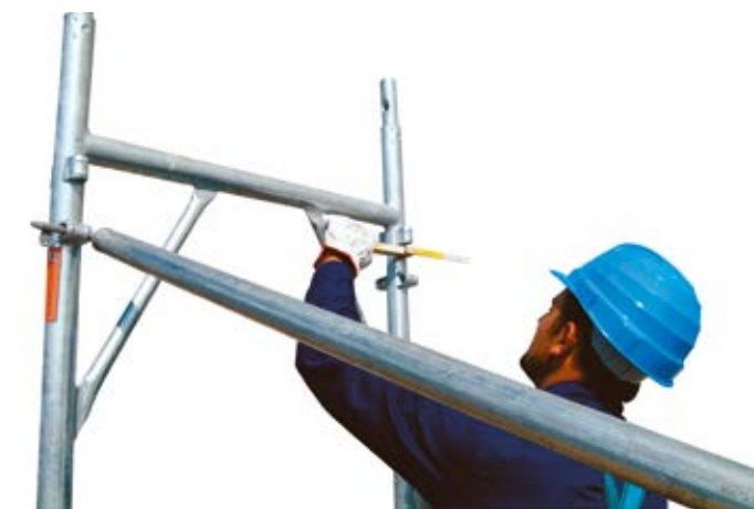
9 • sprawdzenie odległości elewacji
