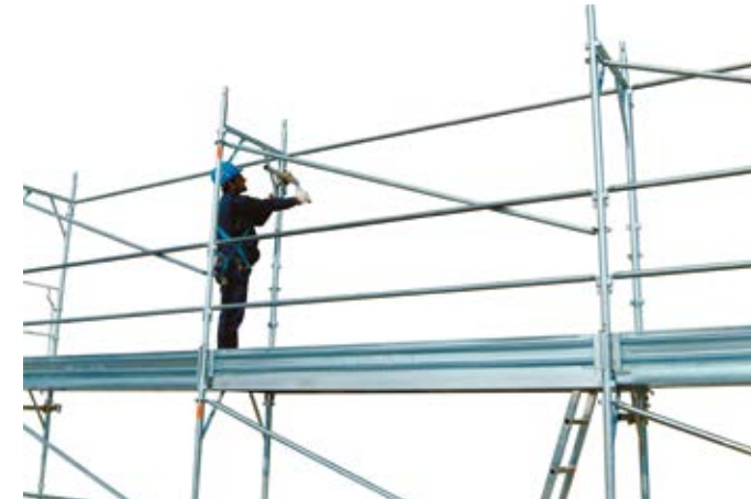
41 • montaż kotwienia na poziomie 1 o ile wymagane
