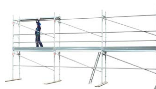
43 • montaż podestów na poziomie 2 cd.
