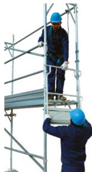
39 • montaż balustrady czołowej na poziomie 1
