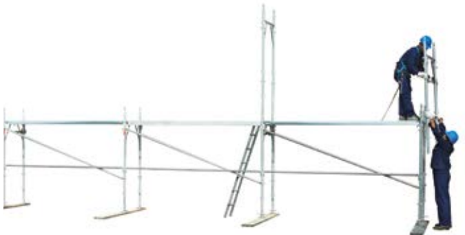
28 • montaż ramy na poziomie 1 cd.
