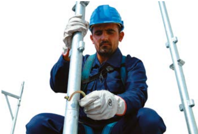
29 • montaż zawleczek do ramy
