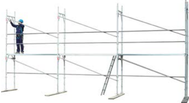
33 • montaż następnych modułów na poziomie 1
