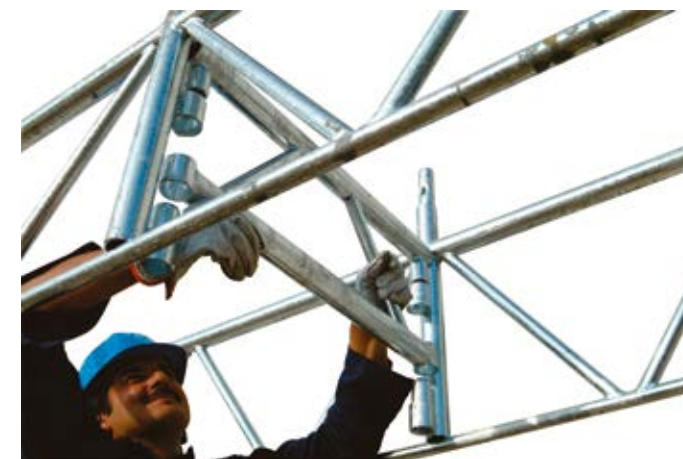
66 • montaż łącznika kratowego kratownicy systemowej
