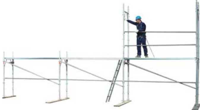
31 • montaż balustrady na poziomie 1
