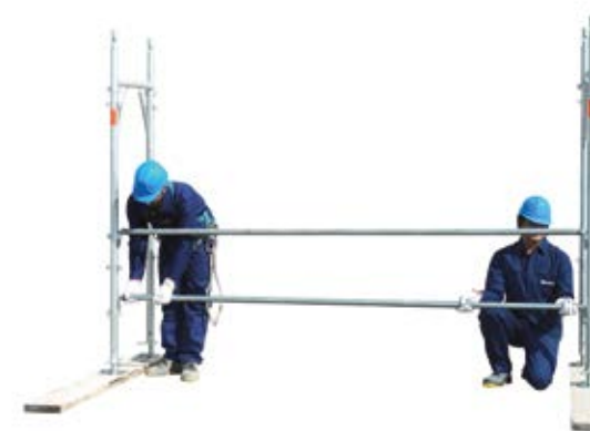
6 • montaż drugiej poręczy
