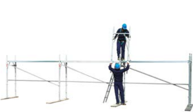
26 • początek montażu ram na poziomie 1
