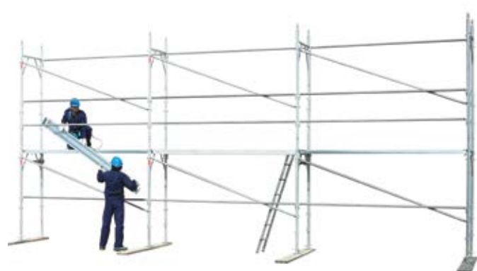
35 • montaż bortnicy na poziomie 1
