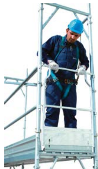
40 • montaż balustrady czołowej na poziomie 1
