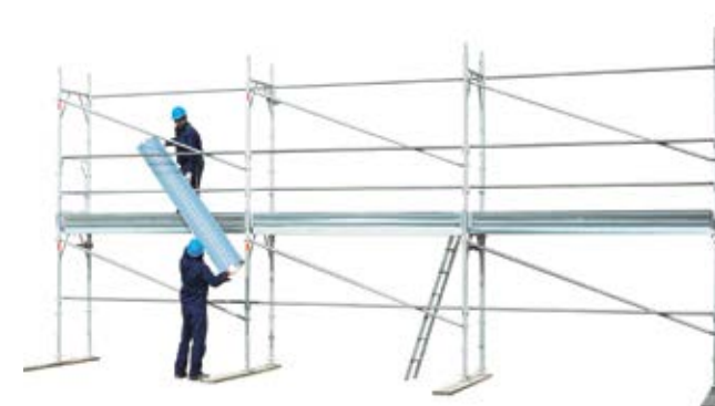
42 • montaż podestów na poziomie 2
