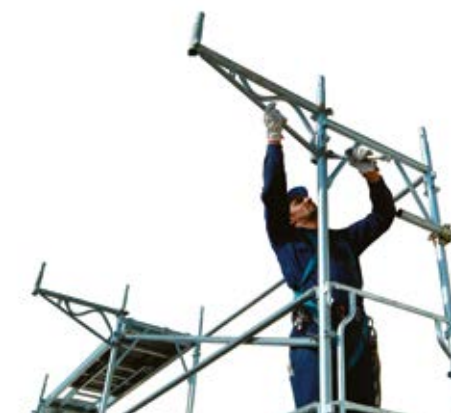
58 • montaż wspornika
