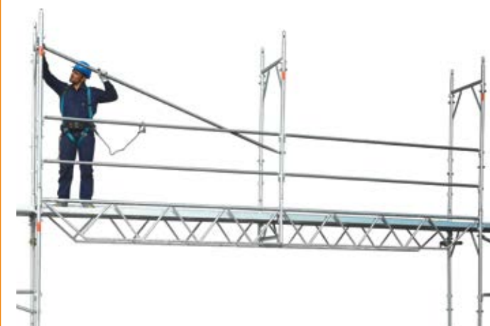
69 • montaż stężeń diagonalnych (krzyżowych) nad kratownicami systemowymi (wzmacniającymi)
