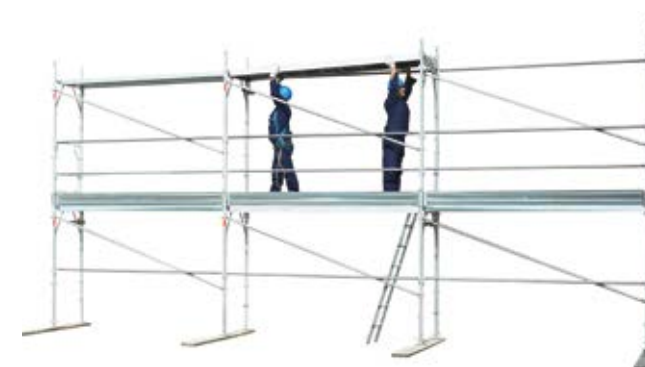
45 • montaż podestów włączowych na poziomie 2 cd.
