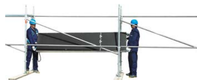
18 • montaż podestu włączowego
