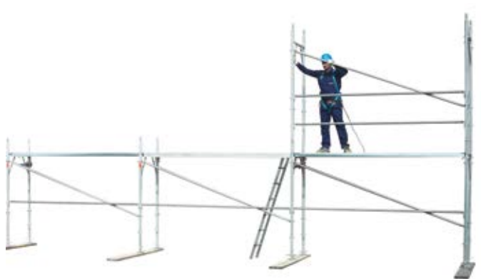
32 • montaż stężenia digonalnego (krzyżowego) na poziomie 1
