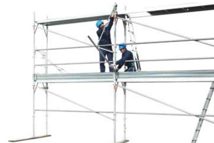
52 • montaż wspornika osłony odpryskowej
