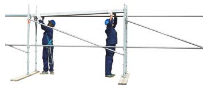
19 • montaż podestu włączowego cd.
