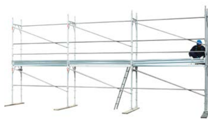
38 • montaż bortnicy na poziomie 1
