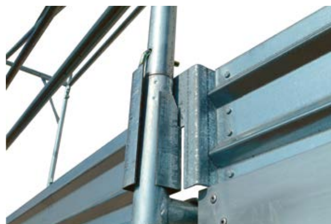
37 • detal bortnicy na poziomie 1
