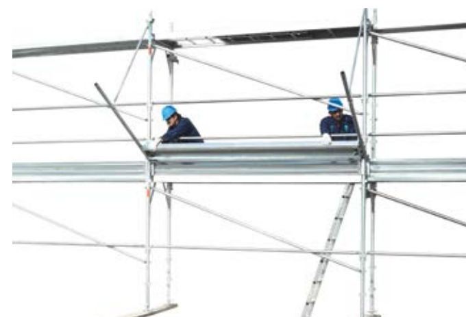
55 • montaż podestów na wspornikach osłony odpryskowej
