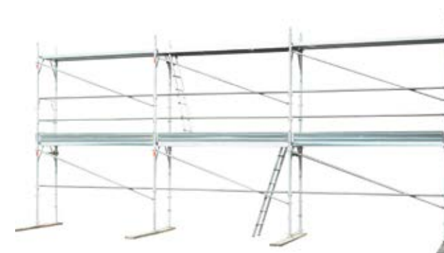
46 • montaż pozostałych podestów na modułach poziomu 2
