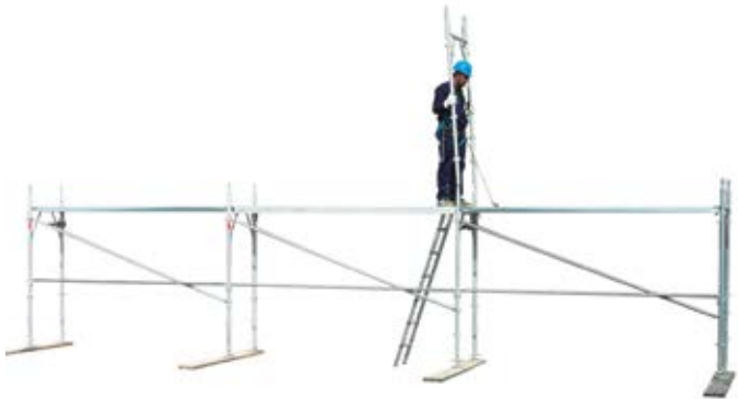
27 • montaż ramy na poziomie 1
